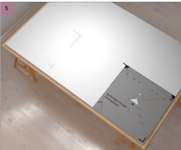
Plaats het markeringshulpmiddel in de rechterbenenhoek aan de achterzijde van het Rockfon Eclipse wandpaneel. Teken de middellijnen met een potlood volgens de linkerbovenhoek van het markeringshulpmiddel en de positie van de afstandshouder.
