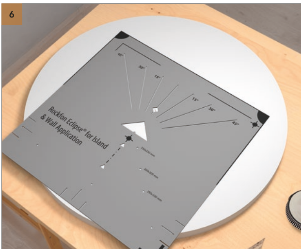
Plaats het markeringshulpmiddel zodat de lijnen uit stap 5, getekend rond de basis van de driehoek van het markeringshulpmiddel, perfect overeenkomen binnen de diamantvormige uitsparing. Zie 6 - Detail.
