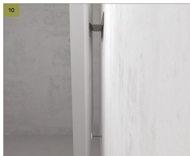
Plaats uw Rockfon Eclipse wandpaneel op het wandbevestigingsprofiel en pas de afstandhouder aan tot het Eclipse wandpaneel waterpas hangt.
