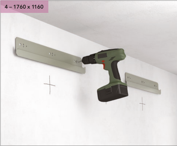
Boor de gaten en installeer het wandbevestigingsprofiel.
